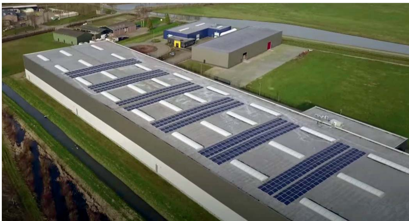
Durch die Installation von 1.100 Sonnenpanelen arbeitet das Unternehmen klimaneutral.
