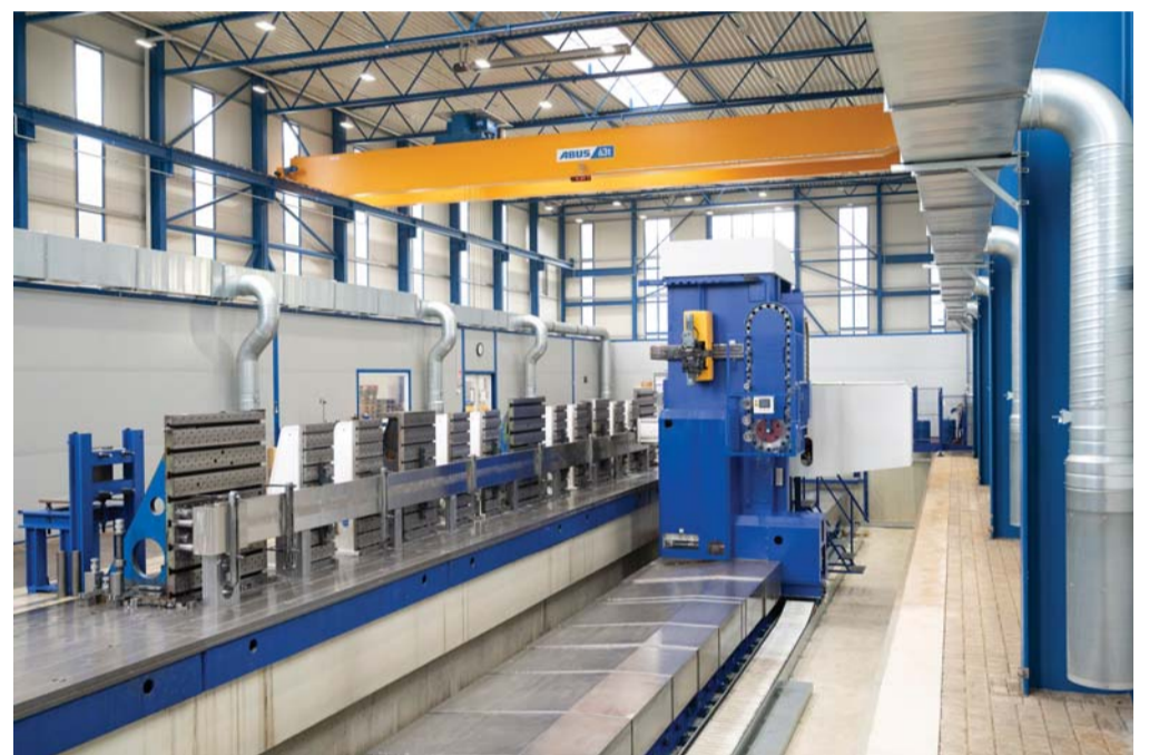
Für Projekte wie ITER müssen konstante Temperaturen gewährleistet und kleinste Toleranzen beim Bearbeiten berücksichtigt werden.
