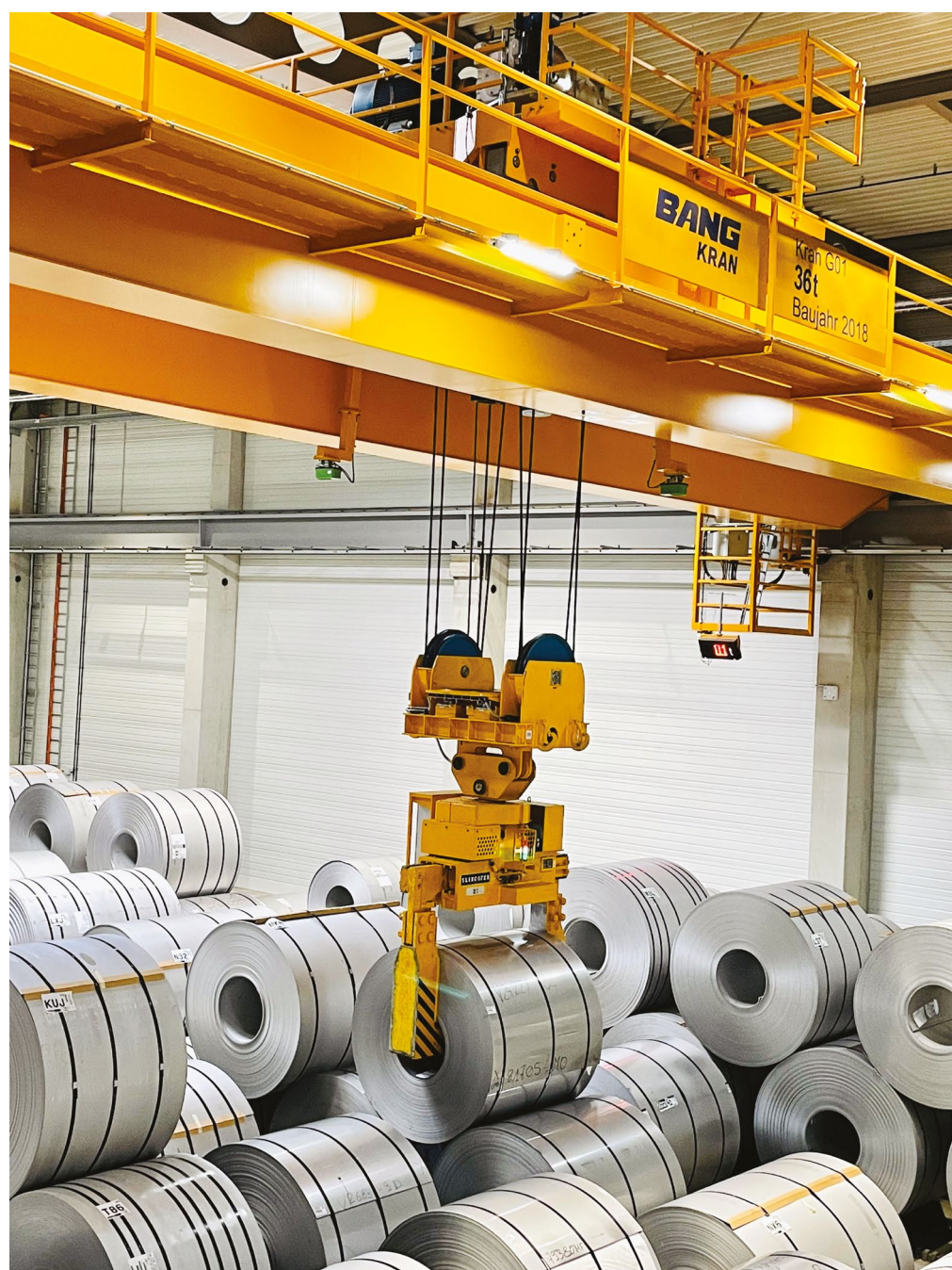
Automatisierte Transportvorgänge, wie der autonom arbeitende Kran, sind Kernelemente des Neubaus in Haan.
