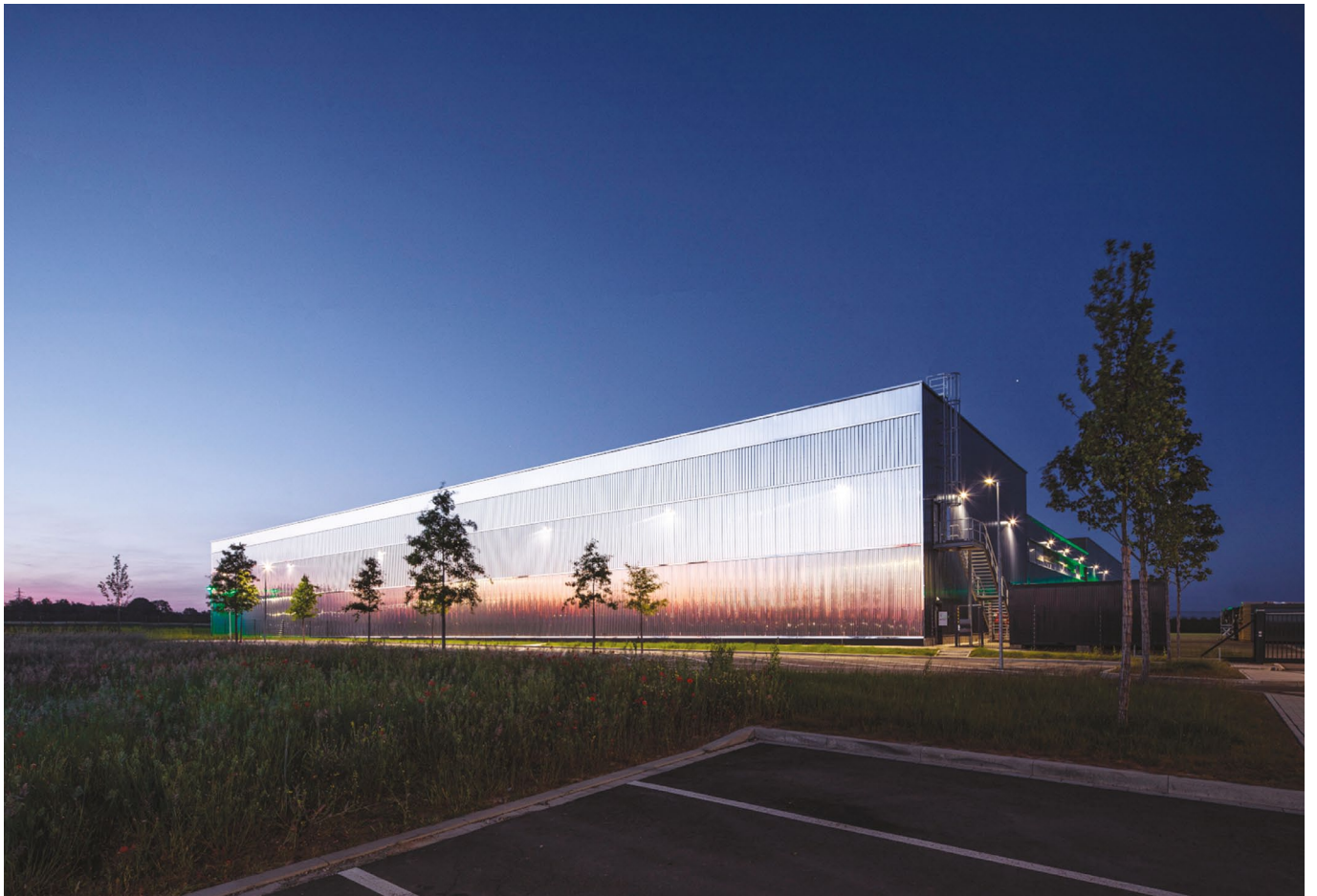
Aperam Service-Center Haan, Fassade aus blankgeglühtem Edelstahl, 1.4301 2R
