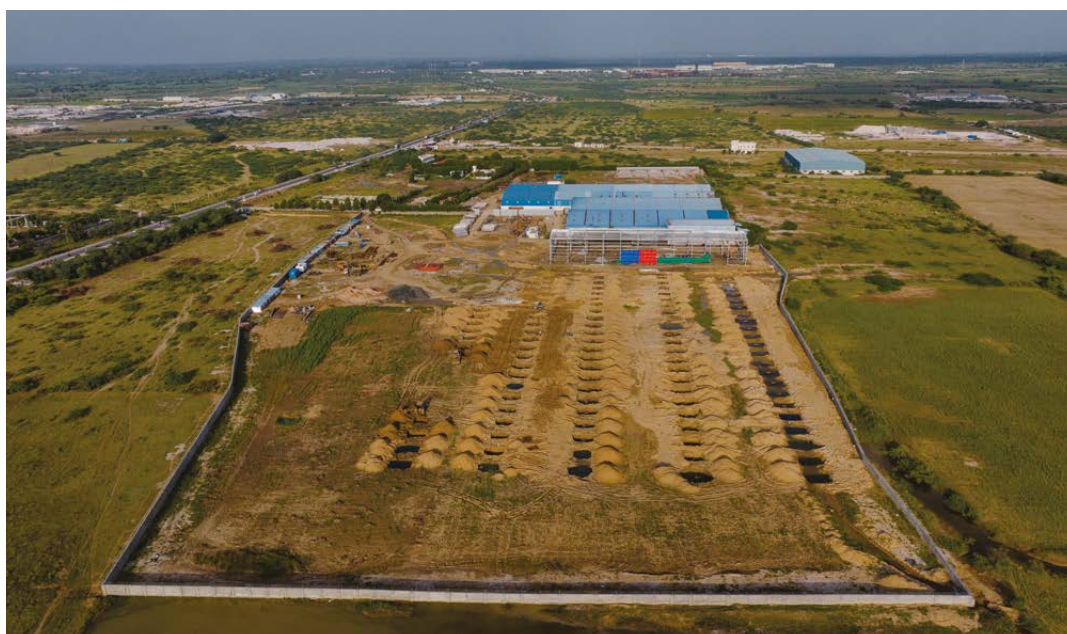
Die Weiterentwicklung des Unternehmensstandorts ermöglicht es Venus, seine Anlagen erheblich zu erweitern und die Produktionsstätte auf 25 Hektar zu vergrößern.
